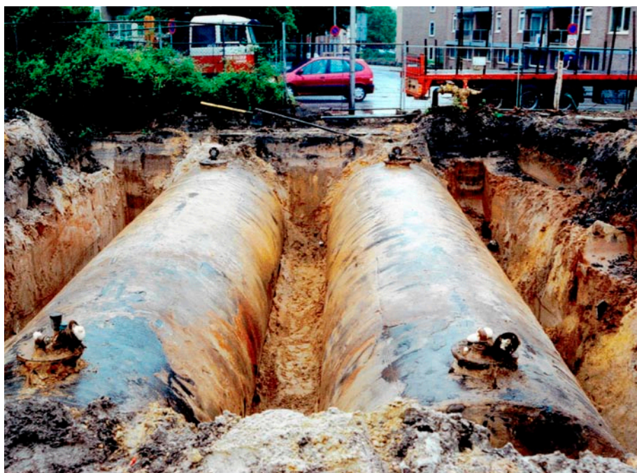
Saneringen van verontreinigde bodems onder tankstations.
