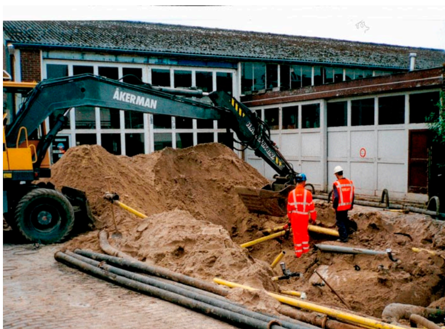
Saneringen van verontreinigde bodems onder tankstations.
